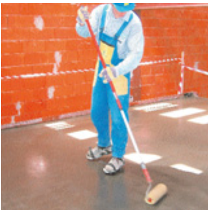
Обработка короткошерстным валиком.
