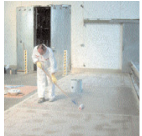
Нанесение валиком грунтовки ASODUR®-GBM
