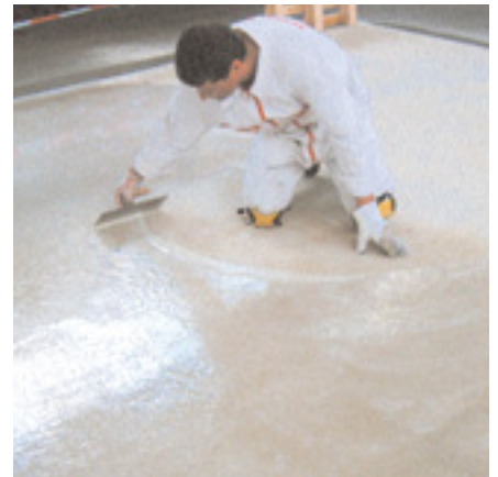
Нанесение грунтовки методом процарапывания
