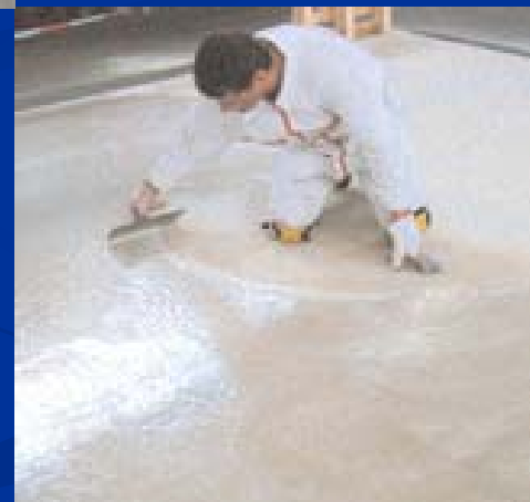
INDUFLOOR-IB 1230 Быстросхватывающаяся грунтовка, (нанесение методом процарапывания)
