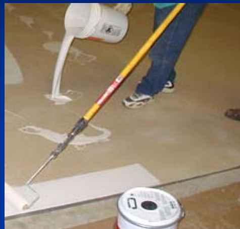
INDUFLOOR-IB 1240 Масло- и пароизоляция (нанесение валиком)
