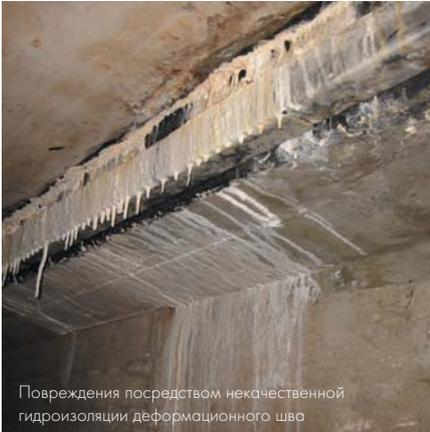
Повреждения посредством некачественной гидроизоляции деформационного шва
