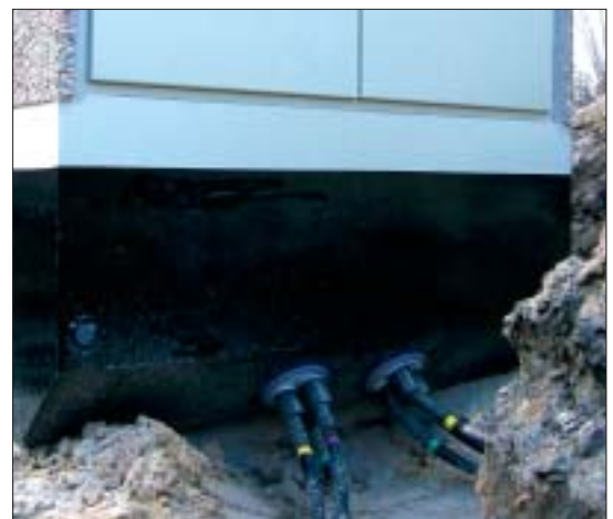
Bild 4 (rechts): UGA-Abdichtung an der Außenseite der Station
