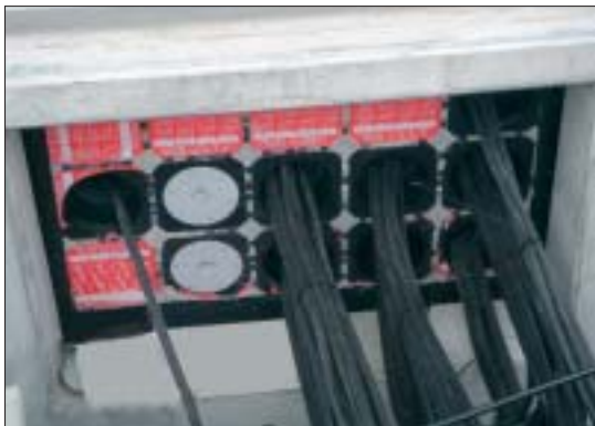
Bild 1: Variable Paketbildung - Einzelne UGA-Dichtpackungen können beliebig neben- und übereinander zusammengesteckt werden (hier 3x5er Paket)
