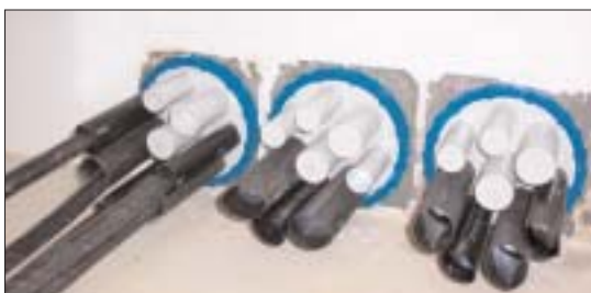
Bild 3: UGA-Systemdeckel mit acht Stützen
